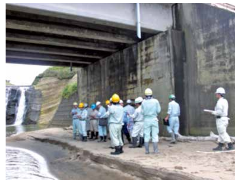
研究会のメンバーによる橋の調査
