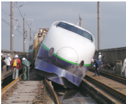
中越地震における上越新幹線の被害
